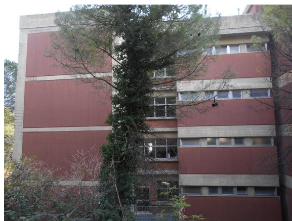
Figura 1.2 - Particolare della facciata retrostante
