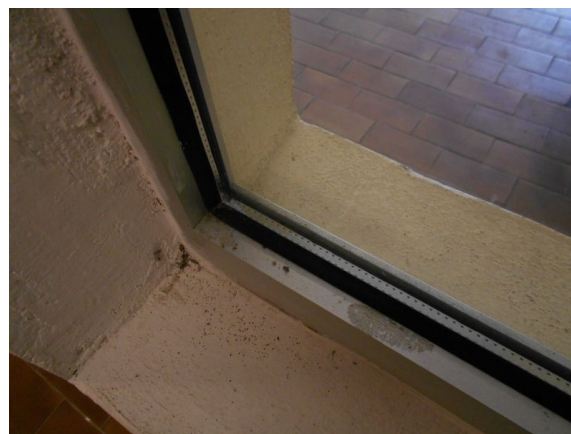
Figura 2.3 - Particolare dei serramenti – dettaglio angolo vetro degli infissi a vetro doppio
