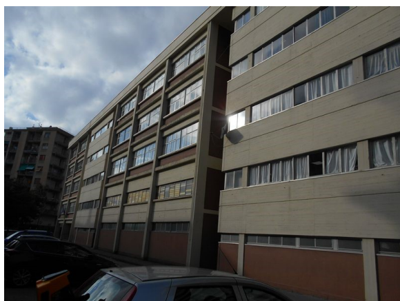
Figura 1.1 - Particolare della facciata principale
